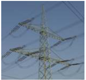
Nachtrassierung von Freileitungen
