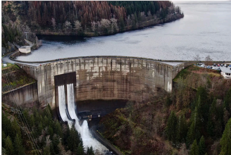
Blick auf die Staumauer der vollen Okertalsperre
